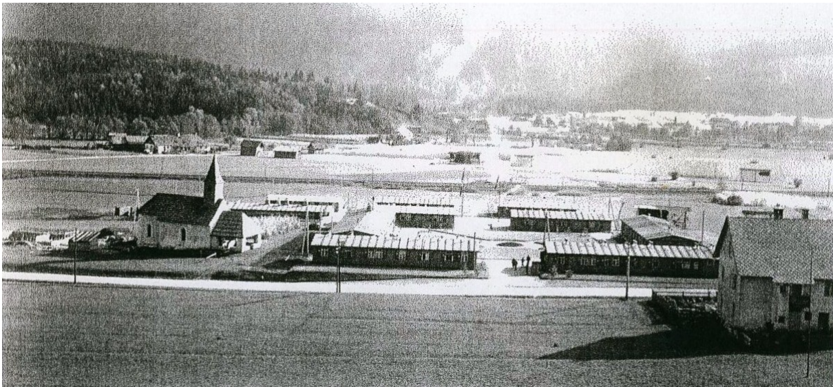
Abb.6: Das damals neu gebaute RAD-Lager in Kühweg. Links neben der Kirche wird gerade die „Führerbaracke“ errichtet. Diese ist bis heute erhalten geblieben. Quelle: Leihgabe Hannelore Berger
